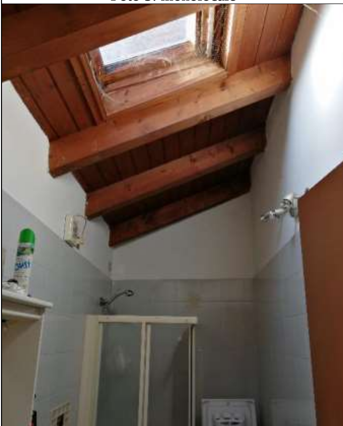
Appartamento sub 30 – P1 Foto 7: soffitto con travi a vista
